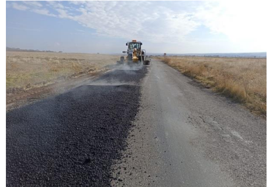
Asfalt Yama Çalışmaları
