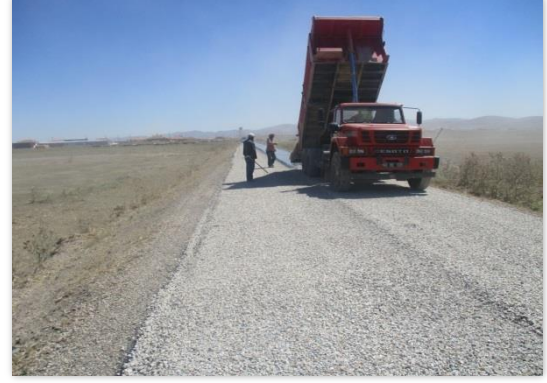
1. Kat Asfalt Çalışmaları
