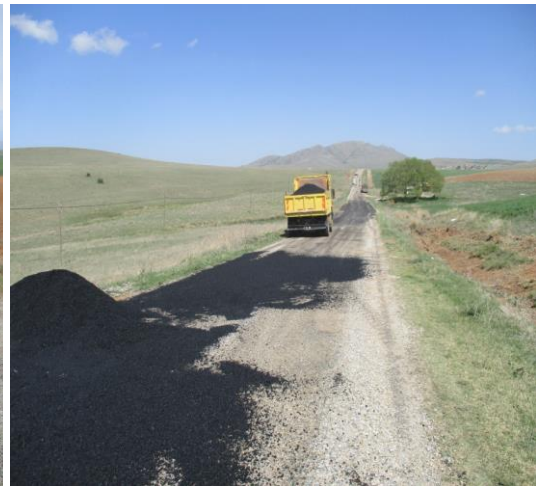
1. Kat, 2. Kat Asfalt Sathi Kaplama ile Yama Çalışmaları
