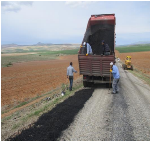
1. Kat, 2. Kat Asfalt Sathi Kaplama ile Yama Çalışmaları
