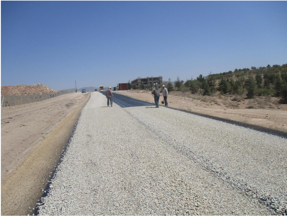
I. Kat, II. Kat Asfalt Sathi Kaplama Yol Çalışmaları
